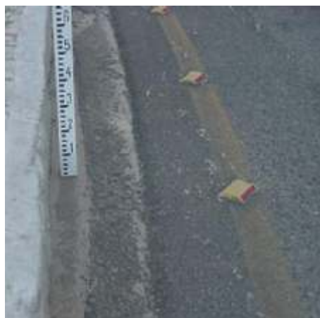
Figura S91 - Sobreposição de Camadas [Fonte: Anel viário do Alto Branco, Campina Grande/PB]
