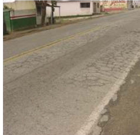
Figura R43 - Remendo com Trincas em Blocos [Fonte: Distrito de São José da Mata, Campina Grande/PB]
