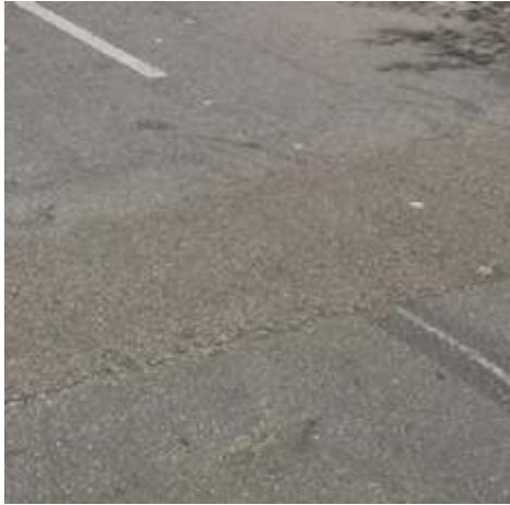
Figura R58 - Nível de deterioração baixo
