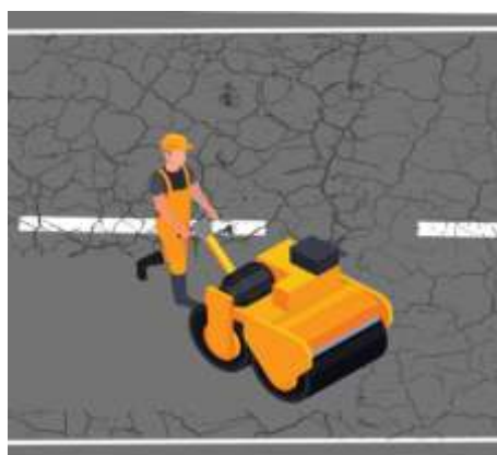
Figura T15 - Execução de um remendo profundo
