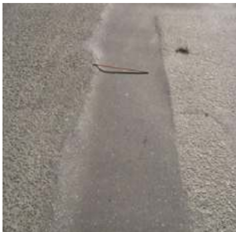
Figura R64 - Nível de deterioração baixo
