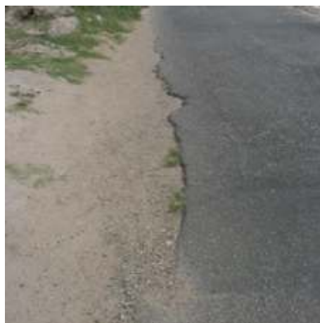
Figura S109 - Falhas no Acostamento [Fonte: Av. Assis Chateaubriand, Campina Grande/PB]
