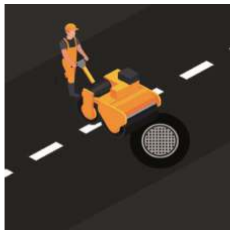
Figura D135 - Fresagem ao redor do tampão de ferro
