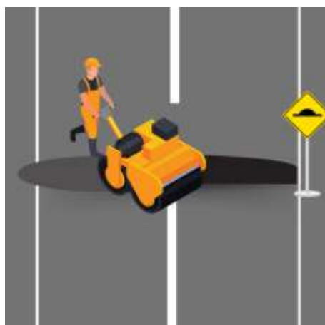
Figura R57 - Compactação para correção do nível da superfície do remendo
