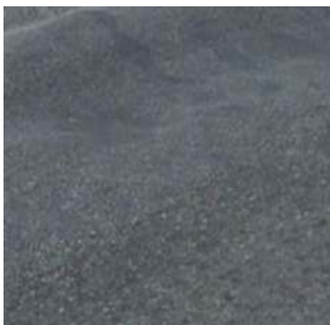
Figura S77 - Nível de deterioração médio
