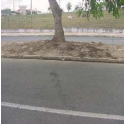
Figura S118 - Nível de deterioração baixo
