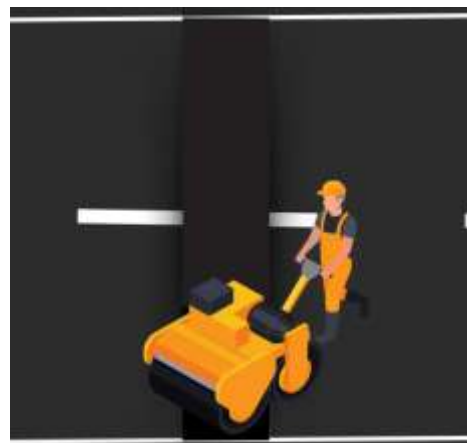
Figura R63 - Compactação para correção do nível da superfície do remendo
