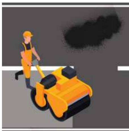
Figura R51 - Execução de um novo revestimento na área afetada
