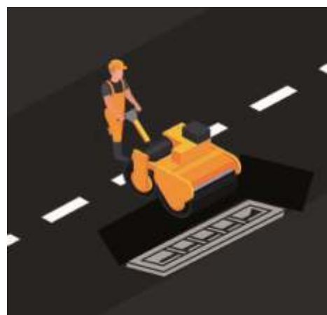
Figura D147 - Fresagem de arremate ao redor da caixa coletora
