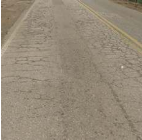
Figura R46 - Nível de deterioração baixo
