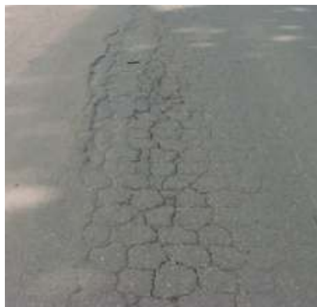
Figura T1 - Trincas por Fadiga em Trilhas de rodas [Fonte: Rua João Quirino, Campina Grande/PB]
