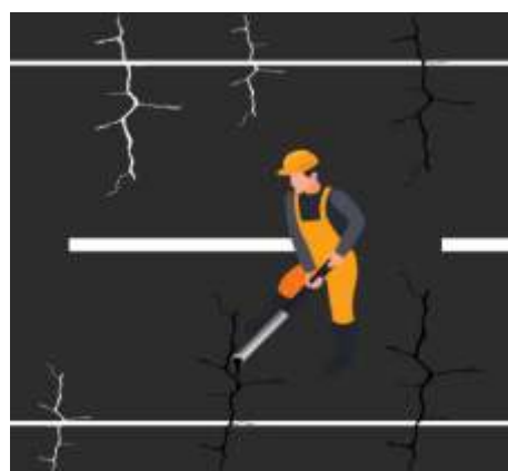
Figura T21 - Aplicação de lama asfáltica
