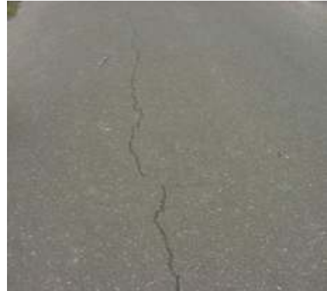
Figura T25 - Trincas Longitudinais [Fonte: Rua Professor Lenier Sucupira Meira de Almeida, Campina Grande/PB]
