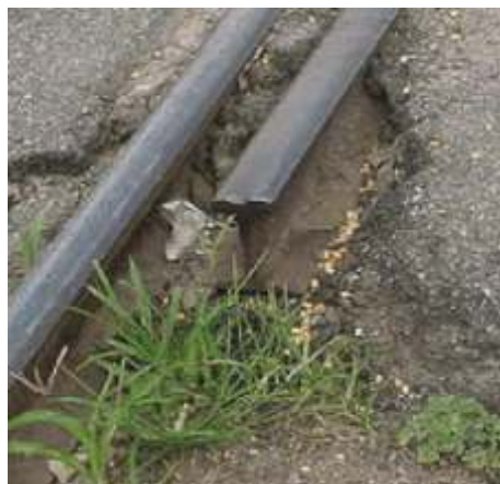
Figura S121 - Ruptura do revestimento nas proximidades de Trilhos de Ferrovias [Fonte: Av. Assis Chateaubriand, Campina Grande/PB]
