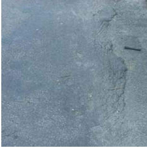
Figura R52 - Nível de deterioração baixo
